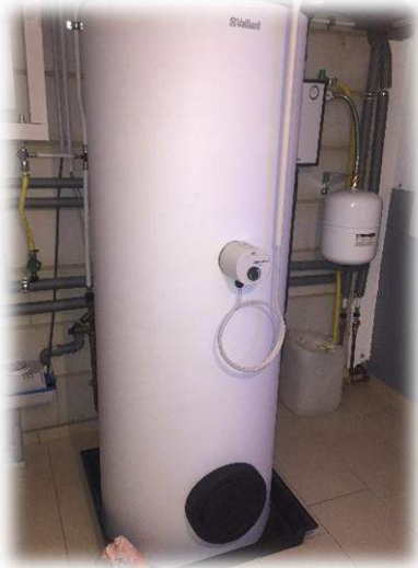
PV-Strom für 2-3 kW Heizstab im Pufferspeicher.
