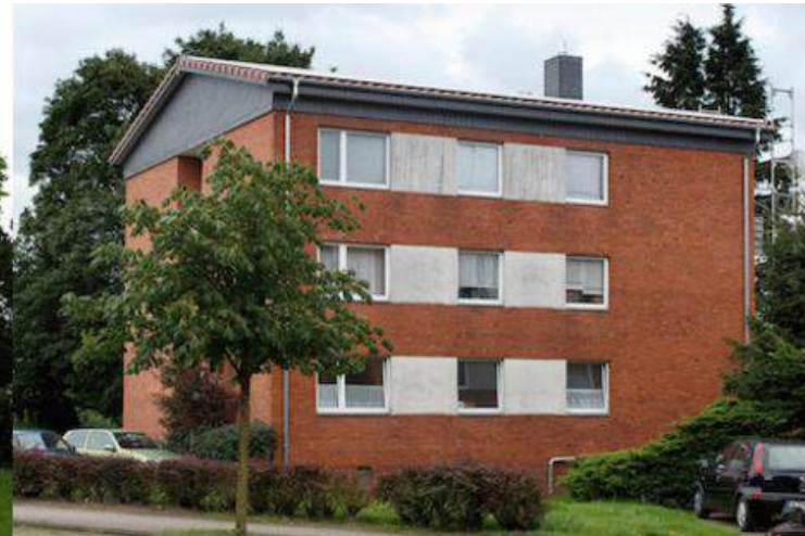
Nach Umbau: mit Satteldach und PV
