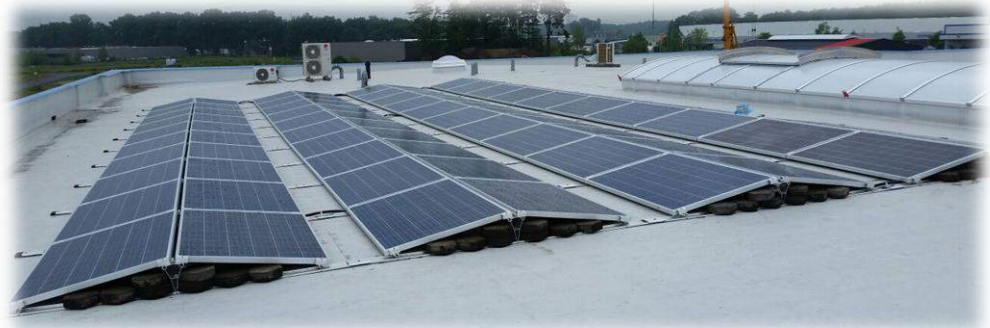
Flachdach mit Ost-Westaufständerung
