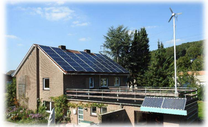
Kombination von PV-Anlage mit Speicher und Kleinwindkraftanlage .
